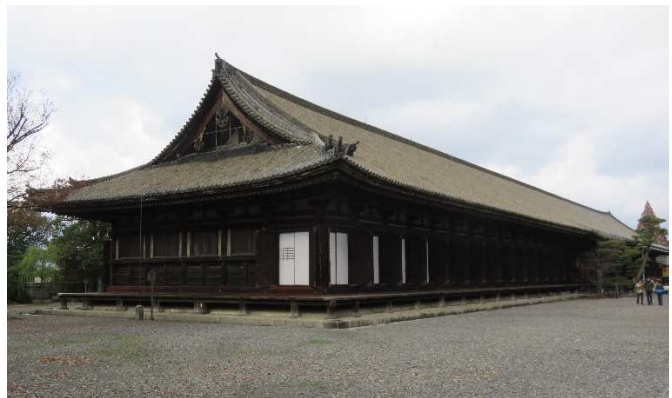
国宝三十三間堂 防犯防災設備改修工事
