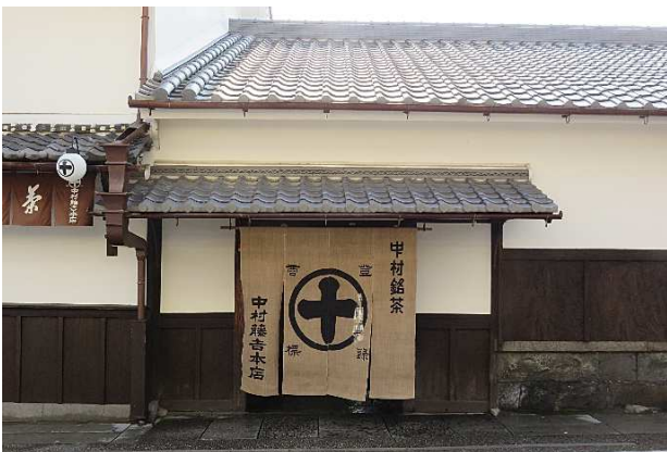
宇治市 中村藤吉本店改修工事
