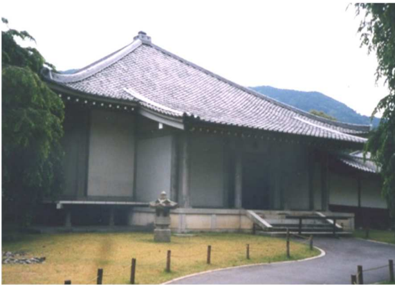
醍醐三宝院 収蔵庫改修工事
