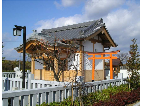
綱敷天満宮神社 新築工事
