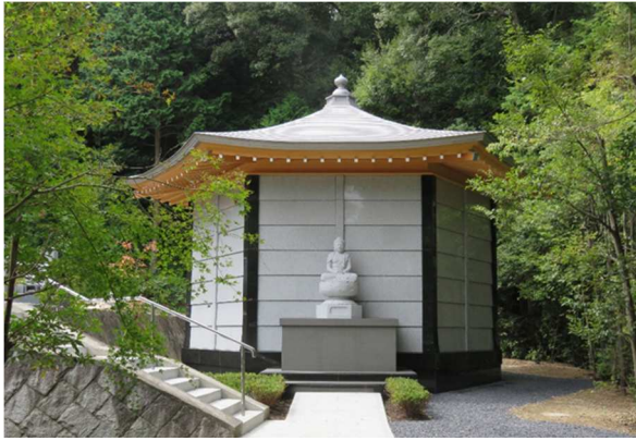
京田辺市 一休寺納骨堂新築工事
