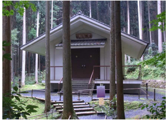
寂光院 収蔵庫改修工事
