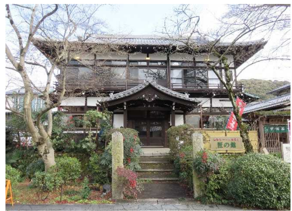
旧京都府茶業会議所 改修工事
