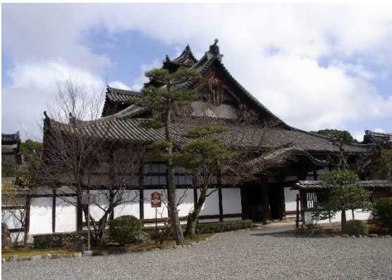
国宝妙法院 庫裡・玄関防災設備工事
